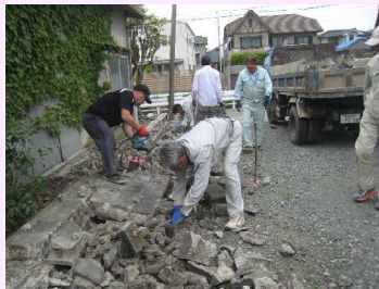
ブロック塀の解体作業
