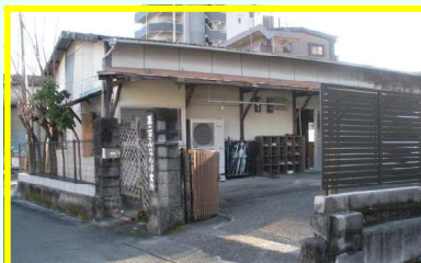
フェンスが設置された作業所
