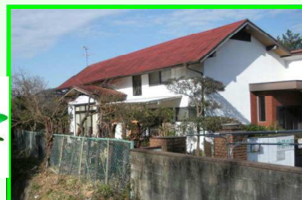
作業後：すっきりと明るい
